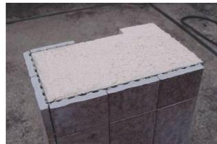
切ったタイルの面に合わせ、ノコギリで発泡スチロール部分を切る。
