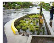
Green Street 道路沿いの緑地の緑を一部空けて、緑地内に雨水を流し込む仕組みになっている。
