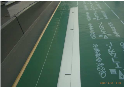
写真④ アルミ製見切り材(入隅用)
