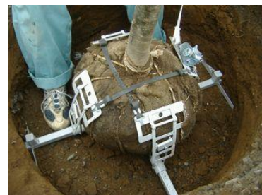
仮止めバンドで仮止め
