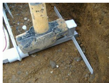
抵抗板を全て打ち込む
